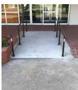
玄関前スロープ
