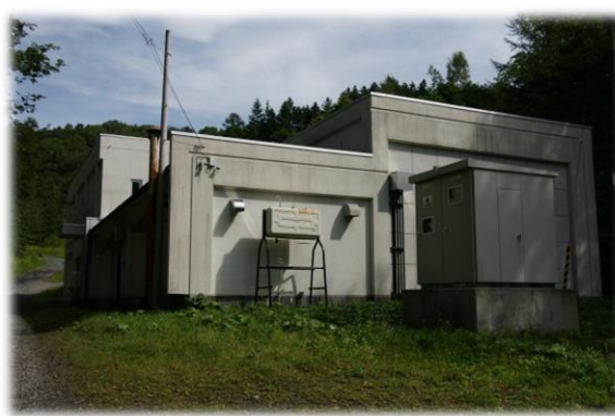
北湯沢浄水場
