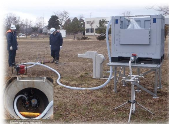
耐震性貯水槽使用時の様子
