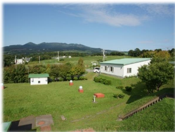
北黄金浄水場配水池
