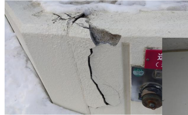
外壁・内壁のひび割れ
