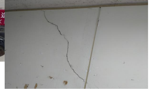
外壁・内壁のひび割れ
