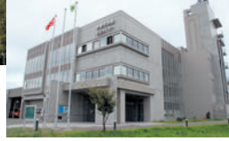
防災センター
