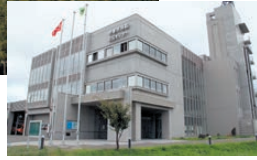
防災センター
