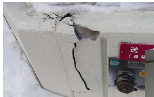
外壁・内壁のひび割れ
