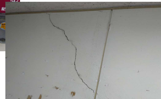
外壁・内壁のひび割れ
