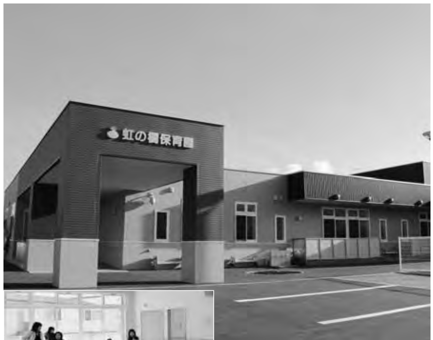
完成した「虹の橋保育園」
