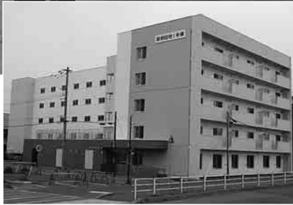
「津波避難ビル」として認定された 駅前団地1号棟
