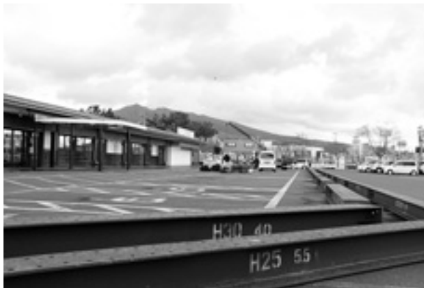
工事用の仮囲いのための土台が設置されました
