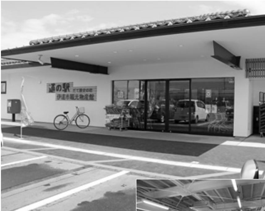
新しくなった物産館の入口横にはポストも設置されました
