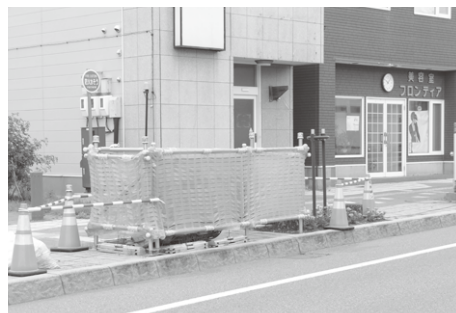
修理中の網代町街路灯配電盤
