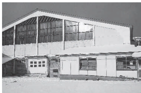
耐震上の問題から改築が急がれる伊達小体育館
